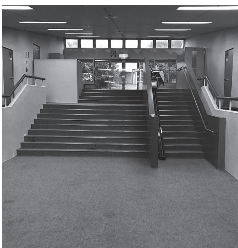
共用スペース
